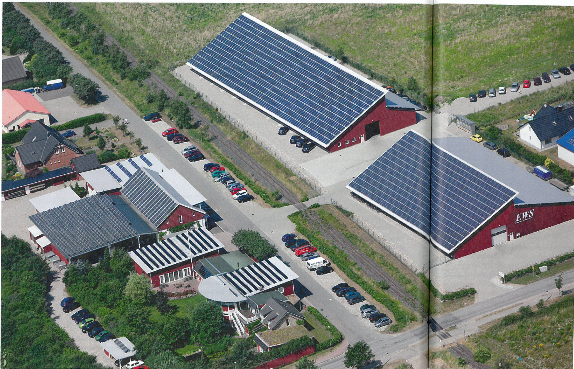
Luftaufnahme des Firmengeländes von EWS in Handewitt: Alle Dächer werden für die Photovoltaik genutzt. Dadurch sinken auch die Betriebskosten des Unternehmens.
